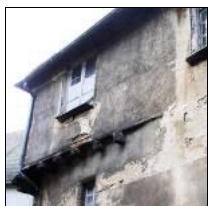
21 rue Vieille. Surélévation en pan de bois.
