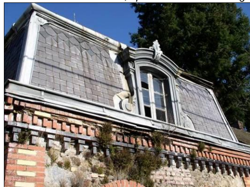
Rue de la Tuilerie. Comble à pente brisée couvert en ardoises et tuiles de zinc. Arêtières, membrons en zinc.
