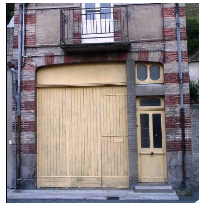
7a Place du Marché. Architecture en brique, arc en anse de panier très plat intégrant la porte du garage, la porte d'entrée et son imposte vitrée
