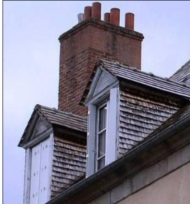
1 rue des Déportés, façade arrière. Lucarnes à chevalet, fronton en bois, joues bardées de bois, toit couvert en tuiles plates.
