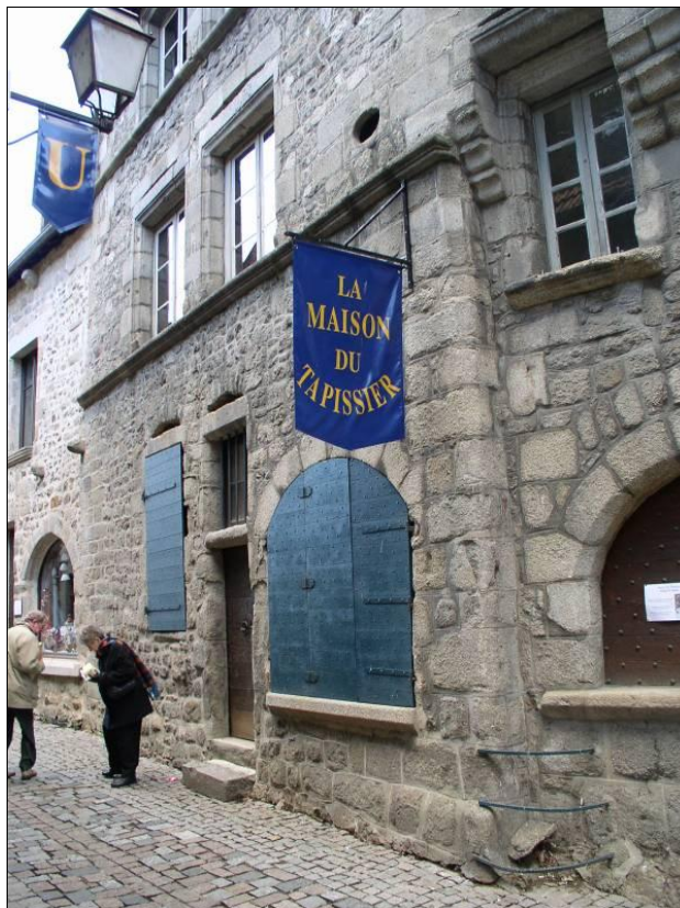
Maison Corneille : bandeaux d'appui séparant 3 niveaux.
