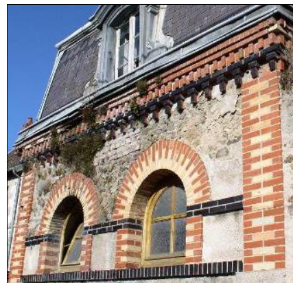
Bâtiment fin XIXe rue de la Tuilerie. Les arcs plein cintre des baies, les jambages, chaînes d'angle, bandeaux et corniche sont en brique, la maçonnerie du mur est en moellons enduits. 3 types de briques : jaune, rouge, vernissée noire.
