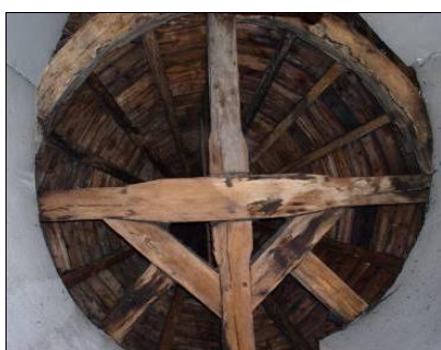
Maison Mage, charpente du toit de la tour d'escalier.
