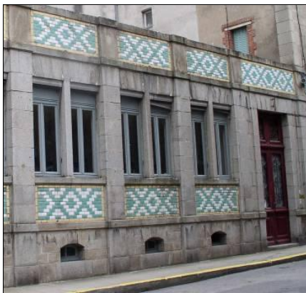
Anciens bains douches, vers 1900, rue Vaveix. Décor géométrique en faïence blanche, verte et jaune, sur les allèges et l'acrotère, dans une façade en granit.
