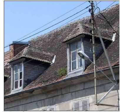
Rue Saint Jean. Lucarnes capucines, couvertes en petites tuiles, arêtiers maçonnés.
