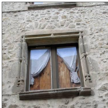
47 rue Vieille : on remarque la reprise de maçonnerie autour de la fenêtre. Sur la façade d'origine, les fenêtres reposaient sur un appui filant ; il a été coupé aux extrémités. Même chose pour la fenêtre au-dessus.
