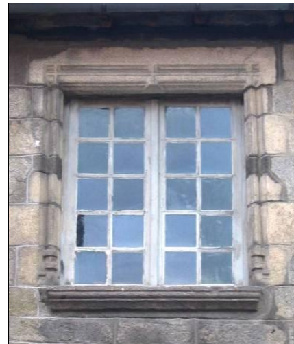
Maison 52 rue Vieille. Réemploi d'une fenêtre Renaissance, encadrement à baguettes fines. Meneau et traverses supprimés.
