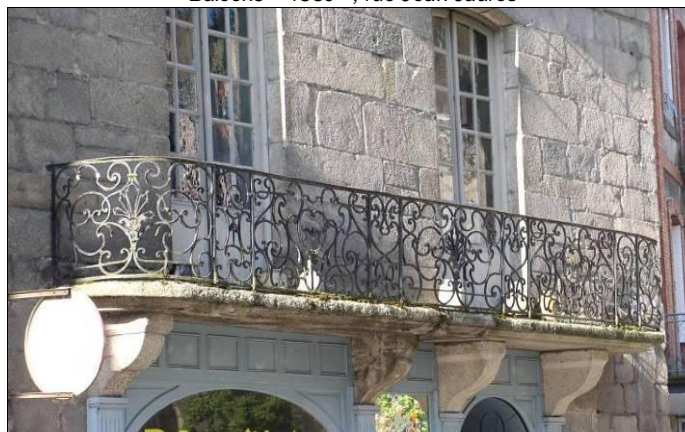
Garde-corps du grand balcon filant de la Maison des Vallenet. Rapporté au XIXe ?
