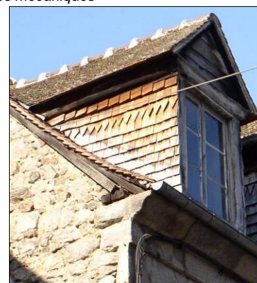
Rive en tuiles plates, chevron apparent, coyau. Egout sur corniche en pierre, moulurée en doucine.. Faîtage de la lucarne en tuiles demi-rondes, avec crêtes en mortier.
