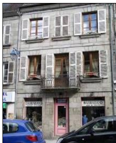
34 rue Vieille. Baie de boutique avec encadrement en pierre et poitrail en bois, dans une façade en moellons enduits. Volets pliants en bois peint (4 panneaux au total), fixés par pentures et gonds.
