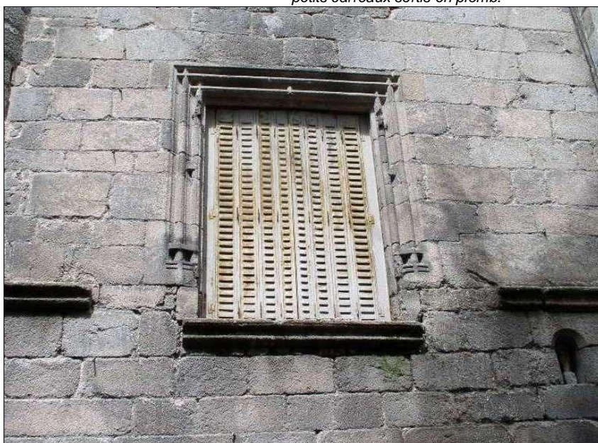
Maison Vallenet. Encadrement à doubles baguettes fines. L'appui Renaissance qui était formé par le bandeau filant a été descendu d'une assise, pour agrandir la baie vers le bas. Les meneau et croisillons ont été supprimés. A une époque on a posé des contrevents en bois, dont il reste les gonds.
