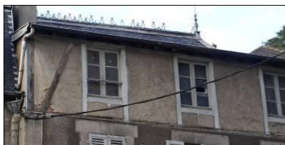
Place de la Libération. Surélévation : 3 e étage en pan de bois, remplissage brique. 2 e moitié du XIXe siècle.
