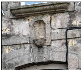
22 rue Châteaufavier. Niche vide au-dessus de la porte d'entrée. Sculptée dans un bloc de granit avec décor floral, coquille ou pétales de fleur au fond, Inscription « 1772 » gravée sur la clef.
