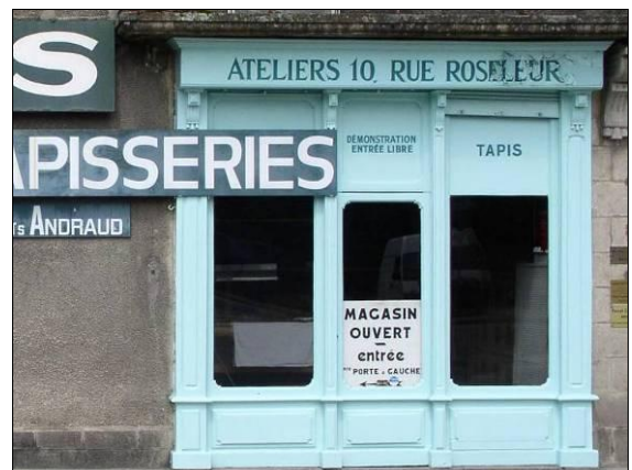
Place Maurice Dayras. Devanture ancienne en bois, plaquée, avec volets roulants métalliques.
