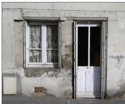
46 rue Vaveix. Très grand linteau d'une croisée monumentale, réemployé en rez-de-chaussée pour la porte et la fenêtre d'une modeste maison XVIIe.
