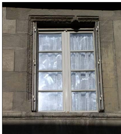
96 rue Vaveix. Grand linteau de croisée partiellement réemployé, avec un seul des deux jambages. Ou la fenêtre a été tronquée ultérieurement : à vérifier à l'occasion d'un éventuel ravalement.
