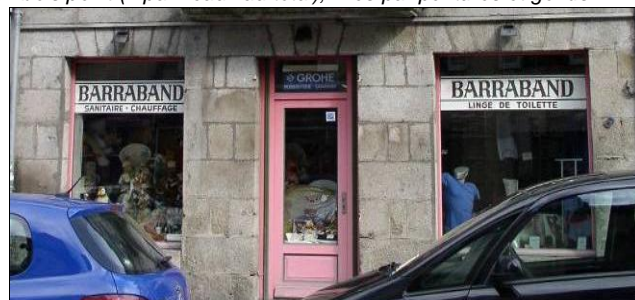
Immeuble 1818, Place Espagne. Plates-bandes appareillées. La façade était destinée à recevoir une devanture en applique.
