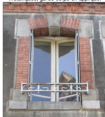
Grande rue. Encadrement brique et pierre. Fenêtre à glace, en bois. Volets métalliques pliants, garde-corps en applique.
