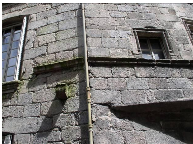
Maison Vallenet : bandeau d'appui. Interrompu au droit des fenêtres agrandies au XVIII e siècle (à gauche)
