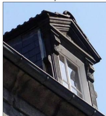
Grande rue. Devant de lucarne en bois peint, fronton triangulaire, deux pilastres cannelés.
