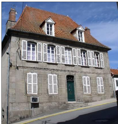
Exemples de composition de façade des années 1770, avec porte aussi haute que les fenêtres. Toutes les ouvertures sont alignées, verticalement et horizontalement. Ci-dessus et ci-dessous.
