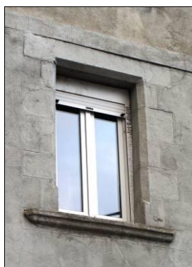
Rue Alfred Assolant. Fenêtre recomposée ? appui réemployé ? Menuiseries inadaptées.
