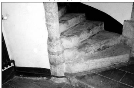
24 rue Châteaufavier. La base du noyau est moulurée, prismatique. Même chose au 26 rue Châteaufavier.
