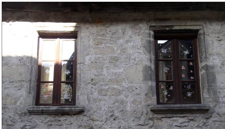
90 rue Vaveix. L'appui de gauche semble avoir été cassé sur le côté droit (réemploi ?)
