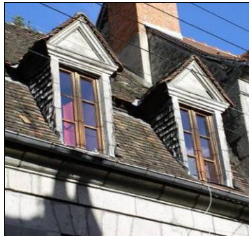
96 rue Vaveix. Lucarnes à pignon avec fronton triangulaire souligné par des moulures, joues bardées d'essentes, toit en tuiles plates avec tuiles d'égout en écailles.
