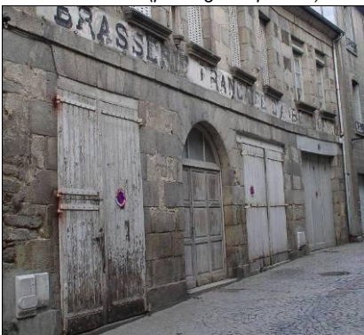
Plate-bande appareillée, soutenue par une poutrelle métallique, arc semi-circulaire. 35 rue Vieille.
