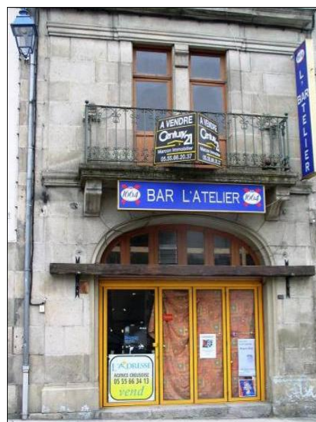
Immeuble 1818, Place Espagne. Plates-bandes appareillées. La façade était destinée à recevoir une devanture en applique.
