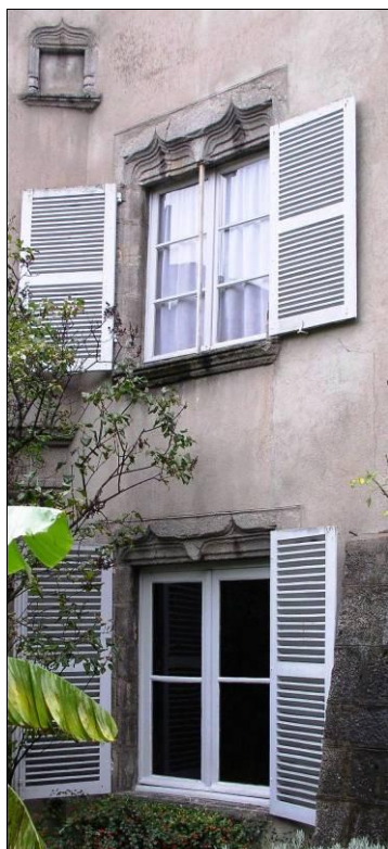
Maison Mage, façade sur le jardin. Fenêtres à double accolade. Meneaux et croisillons supprimés.
