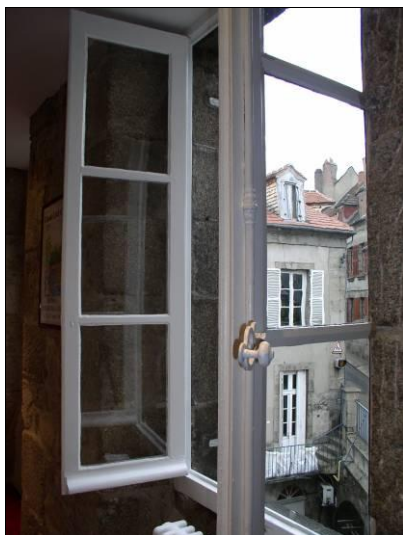
Menuiseries bois (Hôtel de France). Vantaux à 3 carreaux. Montant à noix et gueule de loup ; espagnolette.
