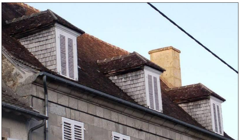
Lucarnes capucines rue Alfred Assolant. Couvertes en petites tuiles, arêtiers profilés au mortier, faîtage en tuiles demi-rondes. Joues bardées de châtaignier.
