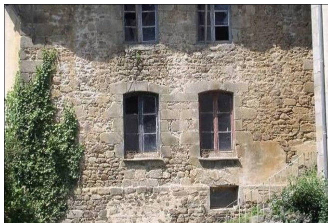
Façades en pierre, XVIIIe, la Terrade. Pierre de taille pour encadrements de baies et chaînes d'angle ; parties courantes en maçonnerie de moellons, destinée à être enduites.
