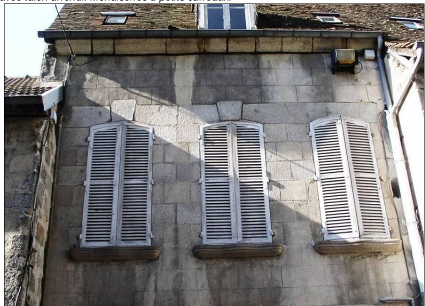
46 rue Vieille. XVIIIe siècle. Travées régulières, fenêtres très hautes, proportion proche de 1 sur 2. Arc semi-circulaire, avec une clef étroite entre deux sommiers très larges qui se rejoignent d'une baie à l'autre. Appuis « en chapeau de gendarme ». Persiennes.
