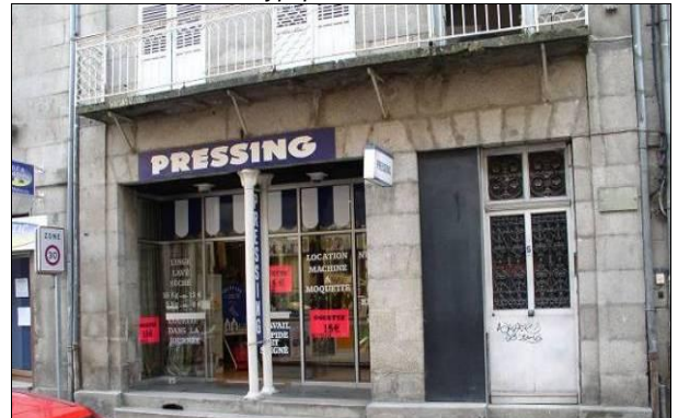
5 rue Vaveix. Plate-bande appareillée, soutenue par une colonne en fonte. Ce type de baie est en principe destiné à recevoir une devanture en applique.
