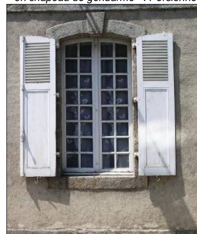
13 rue J.Sandeau. Fin XVIIIe. Arc semi-circulaire avec clef en saillie. Cadre en méplat autour de la baie, y compris pour l'appui. Menuiseries à petits carreaux.
