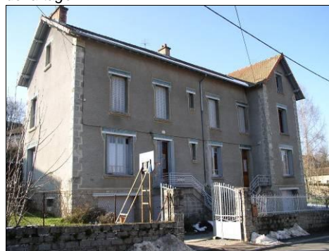
Toiture en tuiles mécaniques sur une maison du début du siècle, rue Pierre d'Aubusson: toit en débord sur le pignon, rives couvertes en tuiles de rives ornées, avec un petit « antéfixe » ou fronton de faîtage.
