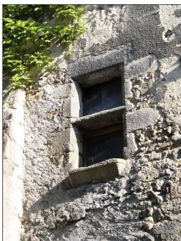
Maison Froment. La traverse horizontale a été conservée. Elle s'inscrit dans l'appareillage de l'encadrement de la baie par une assise de faible hauteur, qui subsiste souvent comme témoin lorsque la traverse a été supprimée.
