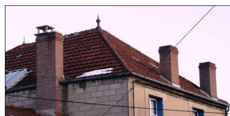
Toiture en tuiles mécaniques, avec tuiles d'arêtier ornées, poinçons en terre cuite. Pente faible.
