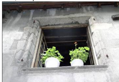
Venelle entre rue Franche et maison Mage. Réemploi d'éléments d'une fenêtre Renaissance, l'appui est un très grand linteau cassé, le jambage de gauche comporte une colonnette avec base et chapiteau ; celui de droite des pierres de jambages disparates. Linteau de taille droite.
