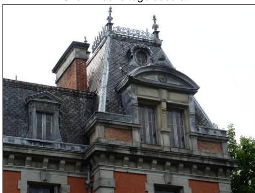
Villa rue Saint-Jean, fin XIXe. Opulente couverture en ardoises en écailles, habillages en plomb des lucarnes à frontons, arêtières, membrons et chéneaux encastrés ; épis et chemins de faîtage.
