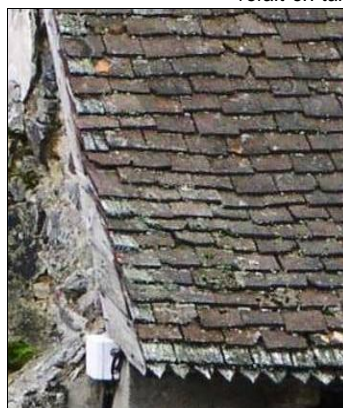
Rives et égout en bardeaux de châtaignier. Sur la rive : 1 rang sur 2 en bardeau, en alternance avec une tuile. A l'égout : bardeaux taillés en pointe. Rue Vieille.
