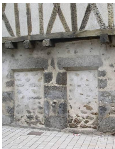
Linteaux monolithes, droits. Encadrements chanfreinés.
