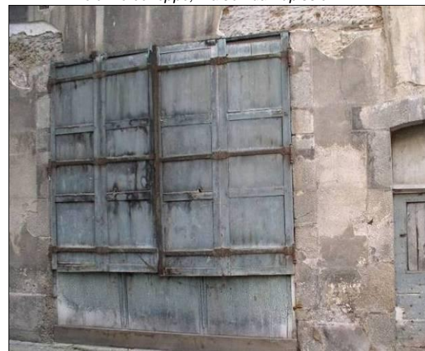
34 rue Vieille. Baie de boutique avec encadrement en pierre et poitrail en bois, dans une façade en moellons enduits. Volets pliants en bois peint (4 panneaux au total), fixés par pentures et gonds.
