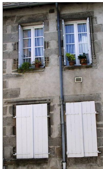
Rue de la Roche. Des morceaux d'une très grande fenêtre à baguettes fines ont été réemployés dans les encadrements de trois fenêtres ordinaires. Réemploi de réemploi ?
