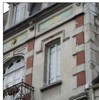
14 place Espagne. Chaînes en brique dans une façade en pierre de taille..
