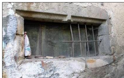
40 rue Vaveix, bâtiment arrière. Réemploi d'un très grand linteau de croisée, pour une petite et grossière ouverture. La date de 1635 gravée sur le linteau serait celle du réemploi.
