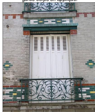
Grande rue. Immeuble vers 1930. Fenêtre dans une façade en brique. Linteau métallique, décor de briques polychromes et vernissées, rouge verte, jaunes, blanches. Volets pliants métalliques, garde-corps en applique.
