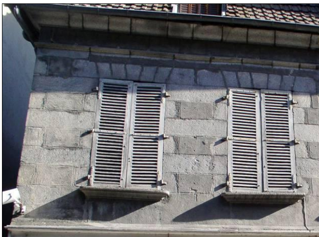
Grande rue. immeuble XIX e , parement en pierre de taille avec au centre des trumeaux, des carreaux remplis en moellons enduits, entre deux blocs de pierre de taille.
