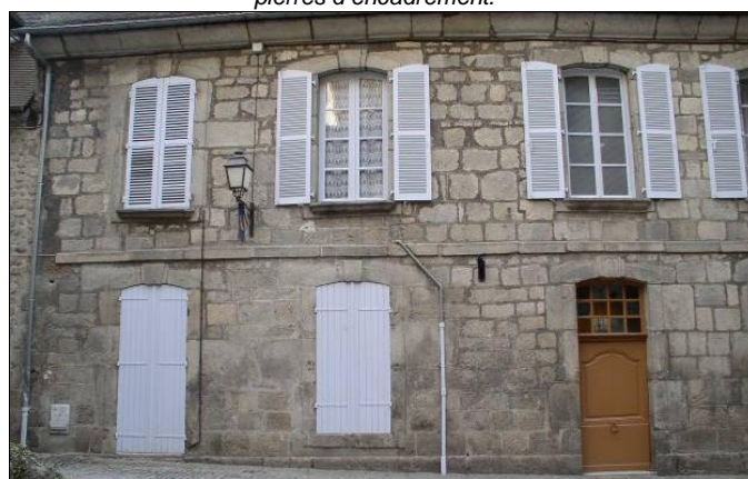
36 rue Vieille. Façade [1772] gravée au-dessus de la porte : Grands moellons, encadrements en pierre de taille, avec ressaut destiné à terminer les surfaces enduites.
