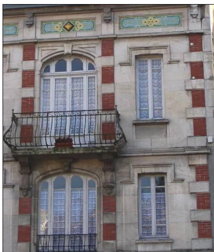
Place Espagne. Immeuble vers 1900. Menuiseries de type début XXe, avec un carreau en bas, un carreau en haut, un très haut carreau entre les deux.
