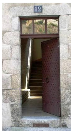
12 quai des Iles. Encadrement XVIIIe siècle. Linteau droit. Porte en planches clouées contrebalancées. Imposte vitrée.
