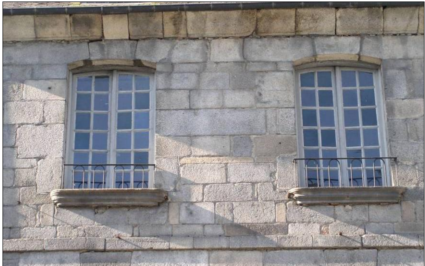
Fenêtres XVIIIe de l'hôtel Vallenet, côté Grande rue. Arc semi-circulaire, appuis moulurés avec talon arrondi. Menuiseries à petits carreaux.
