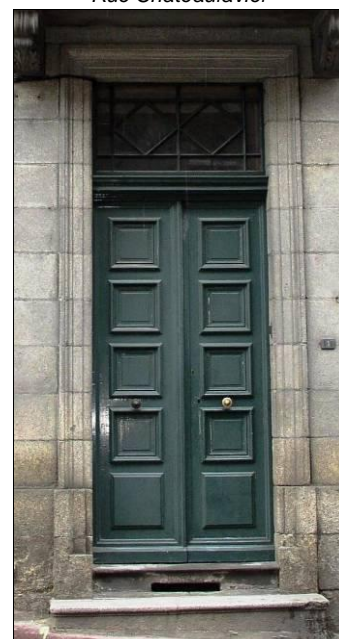
1 rue des Déportés. Encadrement souligné par un chambranle mouluré. Porte à double battant avec imposte vitrée. Menuiserie à cadre et panneaux.
