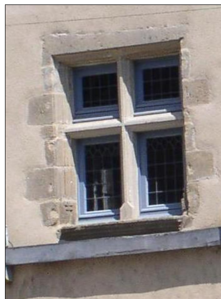
Maison au pont de la Terrade. Meneau et traverse ont été restitués, ainsi que des menuiseries à petits carreaux serts en plomb.
