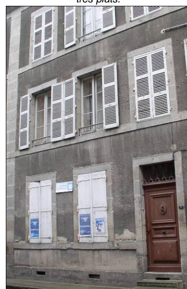
4 rue Jean Jaurès. XIXe. Linteaux droits monolithes, en granit. Menuiseries bois, 3 carreaux par vantail. Persiennes, garde-corps en tableaux.
