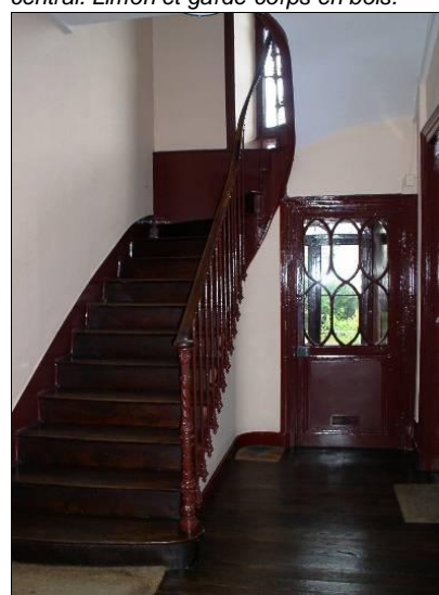
1 rue des Déportés. Départ de l'escalier. Limon en bois, garde-corps en fonte.
