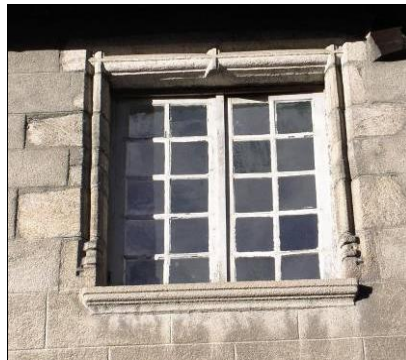
Maison 67 Grande rue. Croisée Renaissance, encadrement à baguettes fines, manque meneau et traverses.
