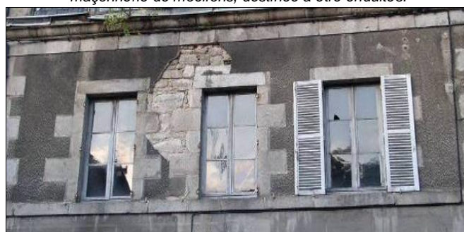
Immeuble XIXe, rue des Fusillés. Même principe de construction du mur. L'enduit sur les parties courantes, est coupé à la truelle autour des baies selon un dessin régulier. Parfois c'est un cadre droit autour de la baie (XVIIIe), parfois comme ici il fait apparaître le harpage des pierres d'encadrement.
