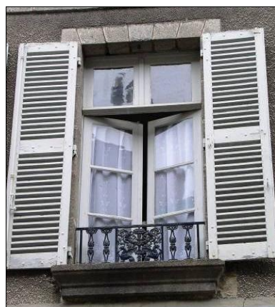
XIXe siècle. Rue Jean Jaurès. Plate-bande appareillée. Fenêtre à grands carreaux avec imposte. Persiennes. Garde-corps en fonte, fixé dans le tableau.
