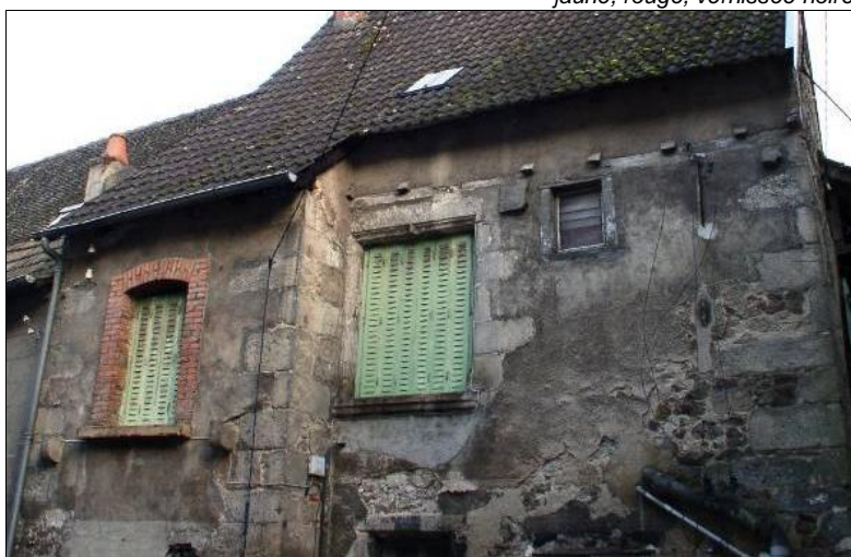
Bâtiment fin XIXe rue de la Tuilerie. Les arcs plein cintre des baies, les jambages, chaînes d'angle, bandeaux et corniche sont en brique, la maçonnerie du mur est en moellons enduits. 3 types de briques : jaune, rouge, vernissée noire.
