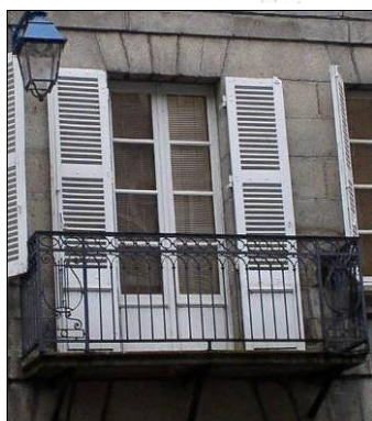
Les portes-fenêtres, fréquentes sur les façades XIXe, reçoivent également des persiennes.
