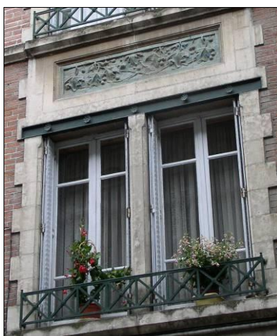
Rue Vaveix. Immeuble début XXe siècle. Même type de menuiseries de fenêtres. Volets pliants métalliques, garde-corps en applique.
