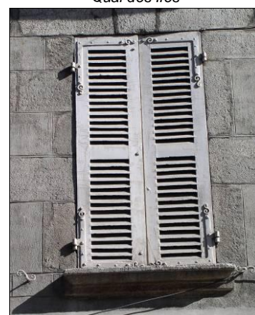
Grande rue. Persiennes Paumelles avec équerres décorées de volutes. Arrêts en forme de volutes.
