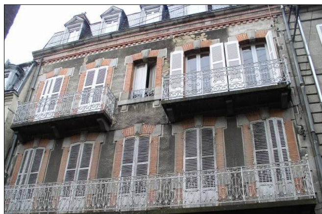
8 rue des Déportés. Mur en maçonnerie de moellons, encadrements de baies et corniche en brique.
