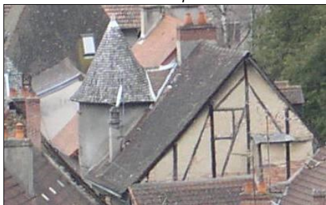
Place de la Libération. Surélévation : 3 e étage en pan de bois, remplissage brique. 2 e moitié du XIXe siècle.
