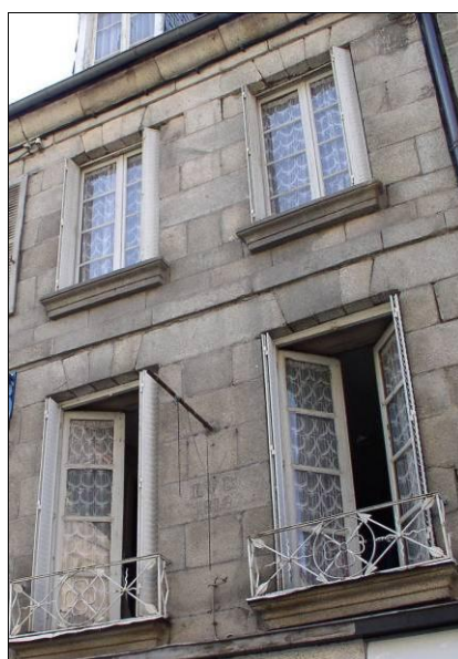
Plates-bandes appareillées. Place Espagne. Immeuble « 1816. »
