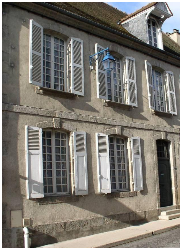
13 rue Jules Sandeau. Bandeau d'étage en méplat, cadres de baies en méplat, clef de l'arc en ressaut, appuis de baies isolés, moulurés.
