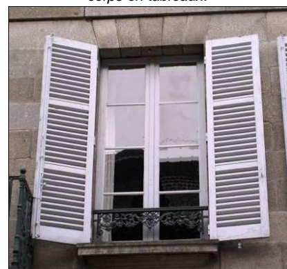
XIXe siècle 1 rue des Déportés. Plate-bande appareillée. Menuiseries à grands carreaux. Persiennes. Garde-corps en tableau.
