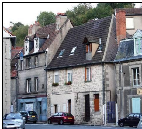
Maisons du XVIIIe siècle, 8 et 10 rue Jules Sandeau, autrefois couvertes en petites tuiles plates, aujourd'hui en tuiles mécaniques.
