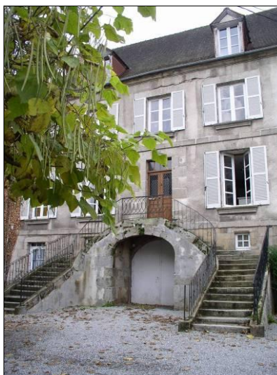
Place Maurice Dayras. Escalier double, comprenant deux volées symétriques, avec partie droite et quart tournant. Palier central, sous lequel se trouve l'entrée de la remise.
