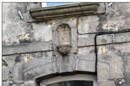
Autre exemple contemporain : 22 rue Châteaufavier, « 1770 ». L'enduit s'arrêtait sur les éléments en pierre de taille, en ressaut de deux cm environ.
