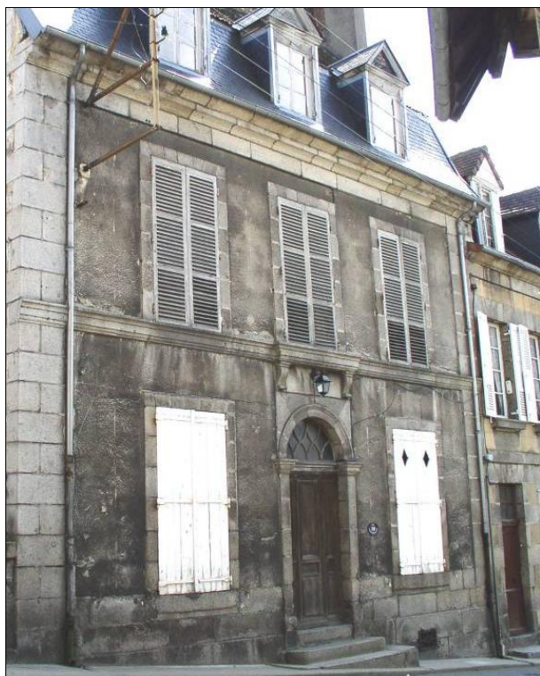
Façade XIX e , 18 rue Châteaufavier. Travées régulières, composition symétrique. Bandeau et corniche moulurés, porte en plein cintre encadrée par 2 pilastres. Cadre en méplat autour des fenêtres.
