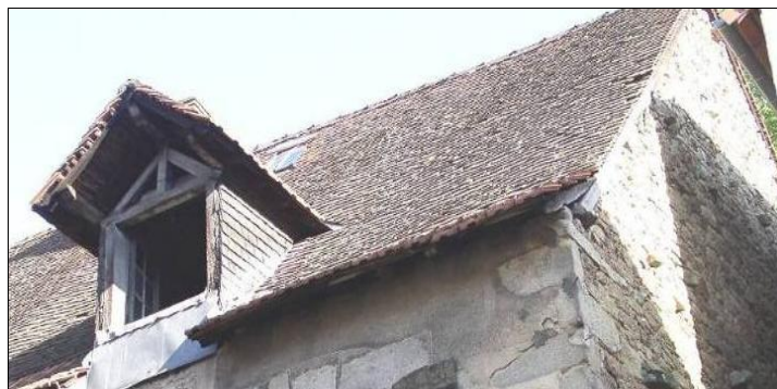
39A rue Vieille, couverture en tuiles plates. On remarque les rives sur chevron apparent, le faîtage en tuiles demi-rondes, la lucarne en charpente avec avant-toit, ses joues bardées en essentes. L'égout pendant a été refait en tuiles mécaniques
