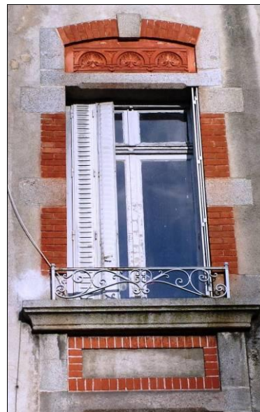
7b rue des Fusillés. Immeuble début XXe. L'encadrement associe le granit, la brique rouge, la terre cuite moulée. Volets métalliques pliants, garde-corps en applique.
