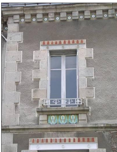
Ecole primaire Villeneuve. Décor de brique polychrome et de carreaux de faïence, sur allèges et corniche.
