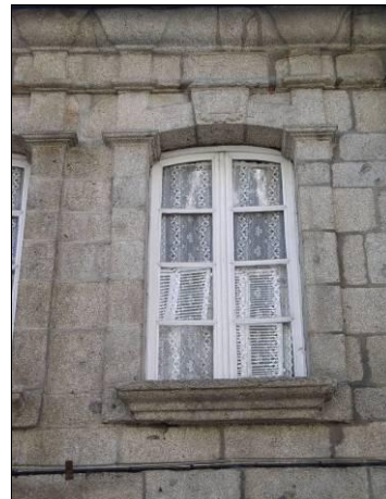
40, Grande rue. Début du XIXe siècle. Exemple atypique. Arc semi-circulaire à 3 claveaux, clef ornée d'un blason en bas-relief, ouverture encadrée de 2 pilastres très plats.
