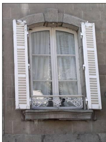
Rue Jean Jaurès. Plus rarement : on trouve aussi des persiennes en bois pliantes, se rabattant à l'extérieur de la baie. Garde-corps en tableau.
