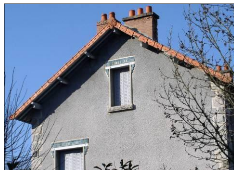
Toiture en tuiles mécaniques sur une maison du début du siècle, rue Pierre d'Aubusson: toit en débord sur le pignon, rives couvertes en tuiles de rives ornées, avec un petit « antéfixe » ou fronton de faîtage.
