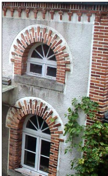
Remise dans la cour du 1 rue des Déportés. XIXe siècle. Encadrement en brique, arc en plein cintre. Menuiseries bois, dessin rayonnant dans la partie cintrée.
